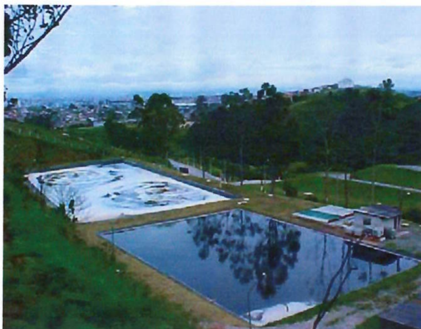
Figura 15 – Estação de Tratamento de Líquidos percolados
